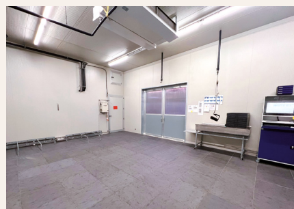
Un nouveau portail extérieur pour permettre le passage de grands appareils.
